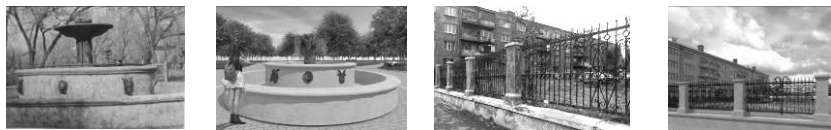
Рис. 1. Малые архитектурные формы: фонтан (состояние в 1998 г. и реставрация); ограды (реальное состояние и реставрация)
